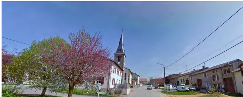
Avant enfouissement des réseaux
